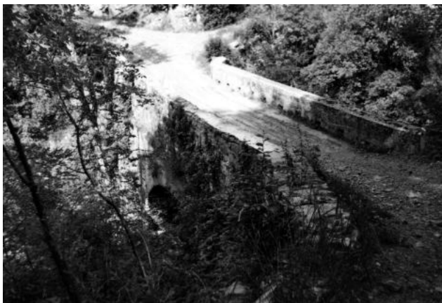
Coli (PC): antico ponte sul rio Curiasca lungo la Via degli Abati
