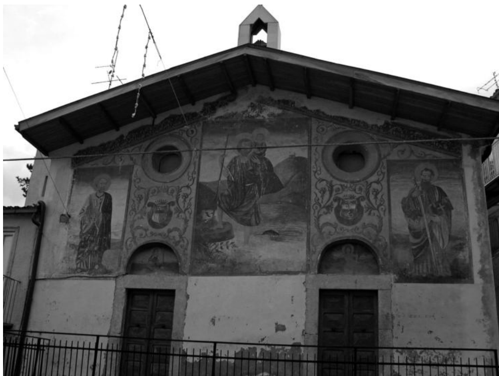
Gildone (CB), chiesa di San Rocco: la facciata
