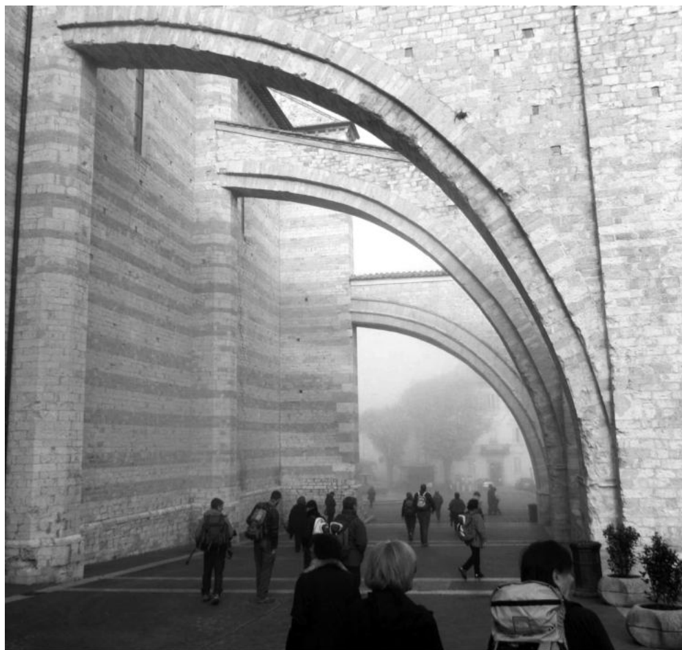
Assisi (PG): particolare dei poderosi contrafforti della basilica di Santa Chiara
